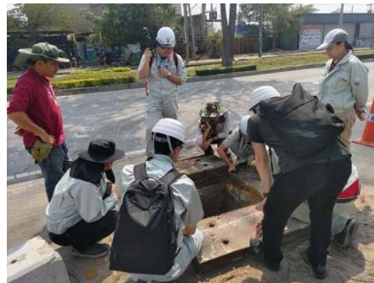
現地：管路調査の様子
