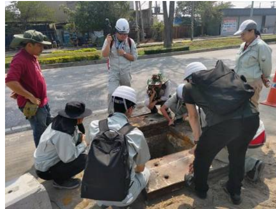
現地：管路調査の様子
