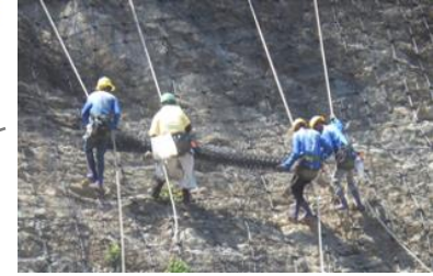
Région d'Hokkaido 51 cas(Exemple : travaux de prévention des risques liés aux glissements de terrain réalisés par une entreprise d'Hokkaido)
