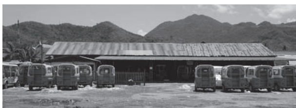
ルアンパバーンの車両基地
