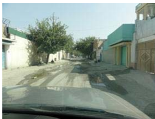
写真—2 コミュニティ道路現況
