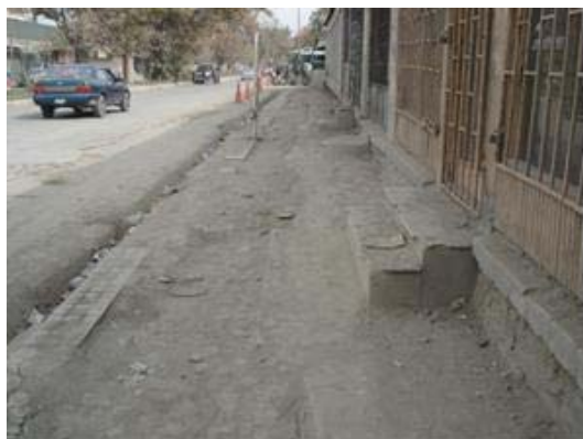
写真—1 基幹道路現況
