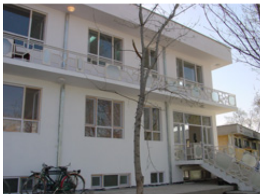
写真1-プロジェクトの中心となった マラライ病院外観
