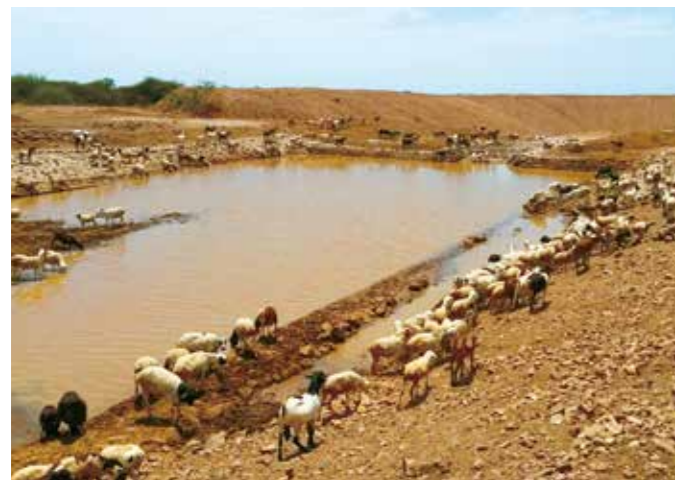
La photo montre un point d'eau pour le bétail construit dans le cadre du projet. Il fournit de l'eau pour de nombreuses têtes de bétail même pendant la saison sèche ou la sécheresse.
