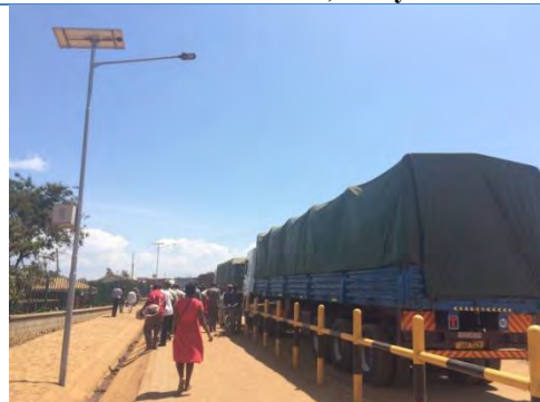
Lampadaire solaire au poste frontalier de Malaba, Kenya
