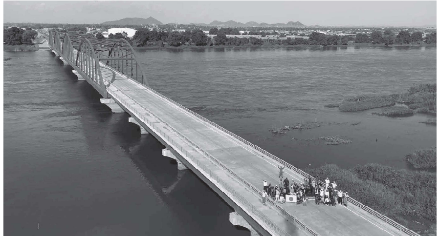
2022年5月に完成したフリーダム・ブリッジ=写真提供:JICA
