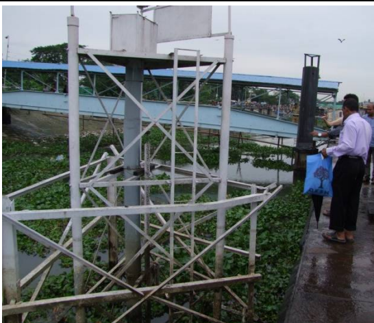
河川港での水位計視察 (BIWTA 管理)
