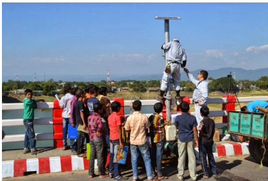
設置工事の様子 (カナイガット Surma 橋)
