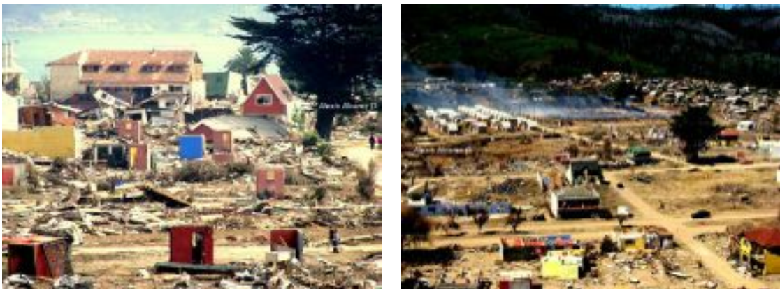
図 1-4 2011 年地震・津波被害の様子 18
