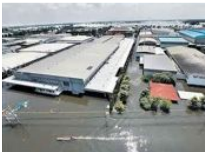
図 1-1 2011 年の洪水で浸水した工業団地 10
