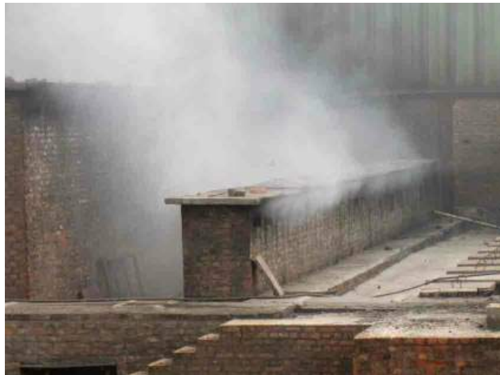
写真 1-4 ハイブリッドホフマン窯の排気口からでる煙
