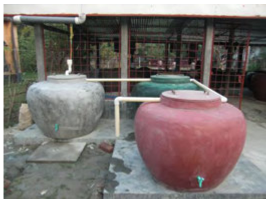
写真 9-9 工場に設置された AMAMIZU システム
