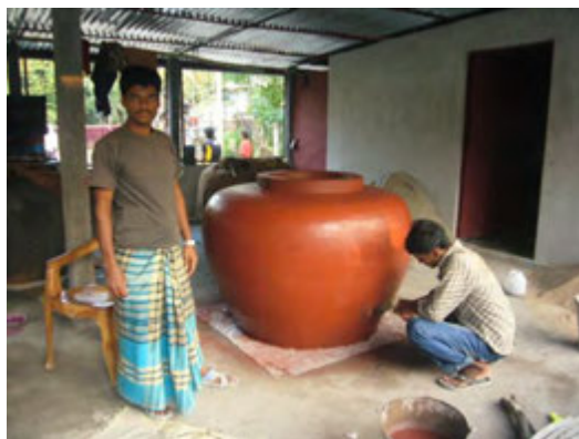
写真 9-8 色セメントによる仕上げ
