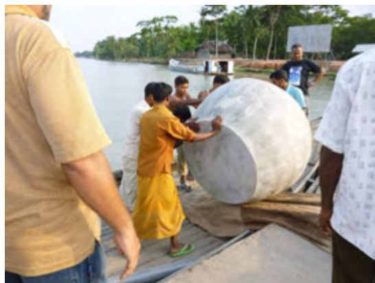
写真 9-34 船へのタンク積み込み
