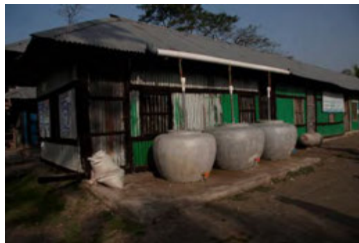
写真 9-22 バス停に設置されたタンク
