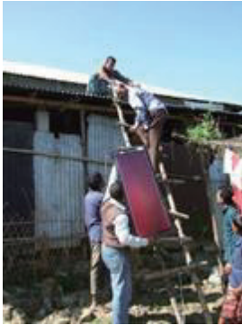
20W パネルの設置
