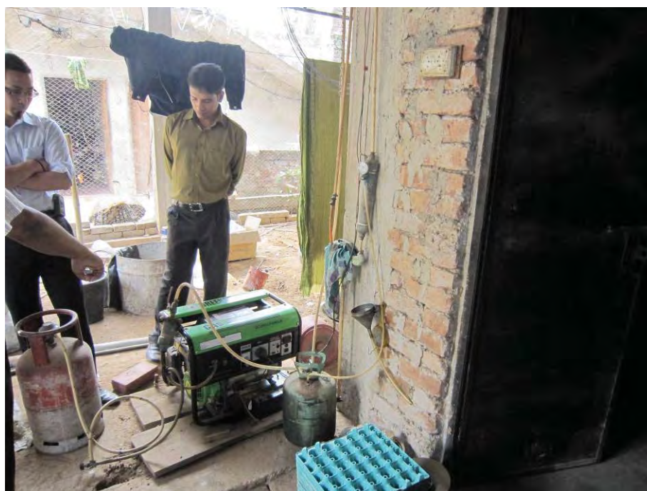
図 30: 小型の非常用ガスエンジンの利用事例
