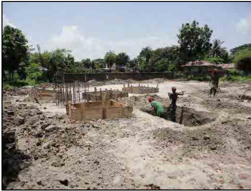
写真 33 選別施設用地(着工事)
