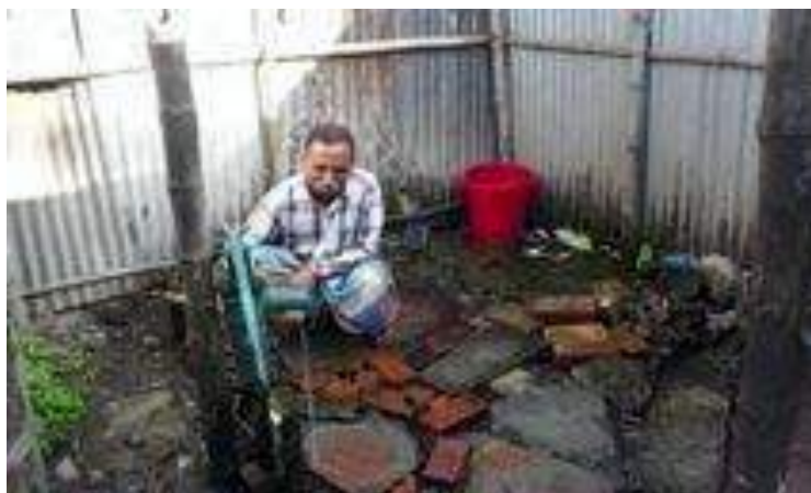
図 3-3 地区内に設置されている給水拠点
