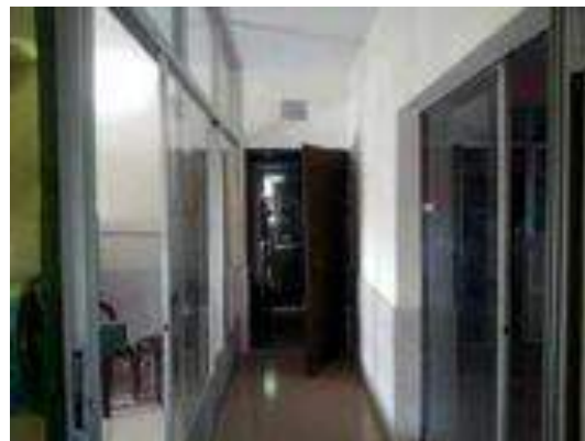
充電室の仕切り（左側）
