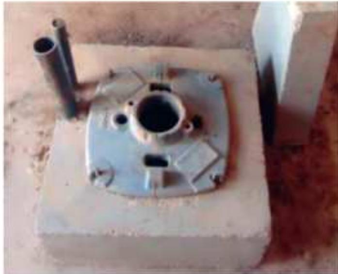
**Figura 10 - Protector de tubería de ademe y Base soporte de bomba**
