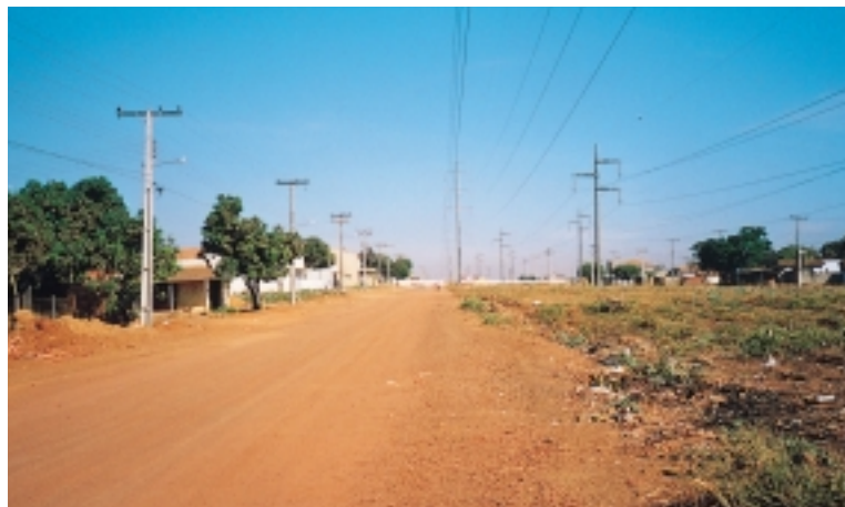
建設された送電線
