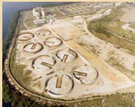
アレグリア下水処理場
