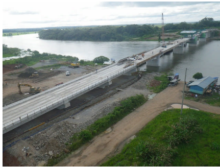
11月時点の橋梁建設状況
