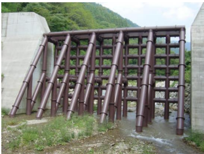
Figura 25. Exemplo de barragem Sabo permeável (Mizuyama, 2008)
