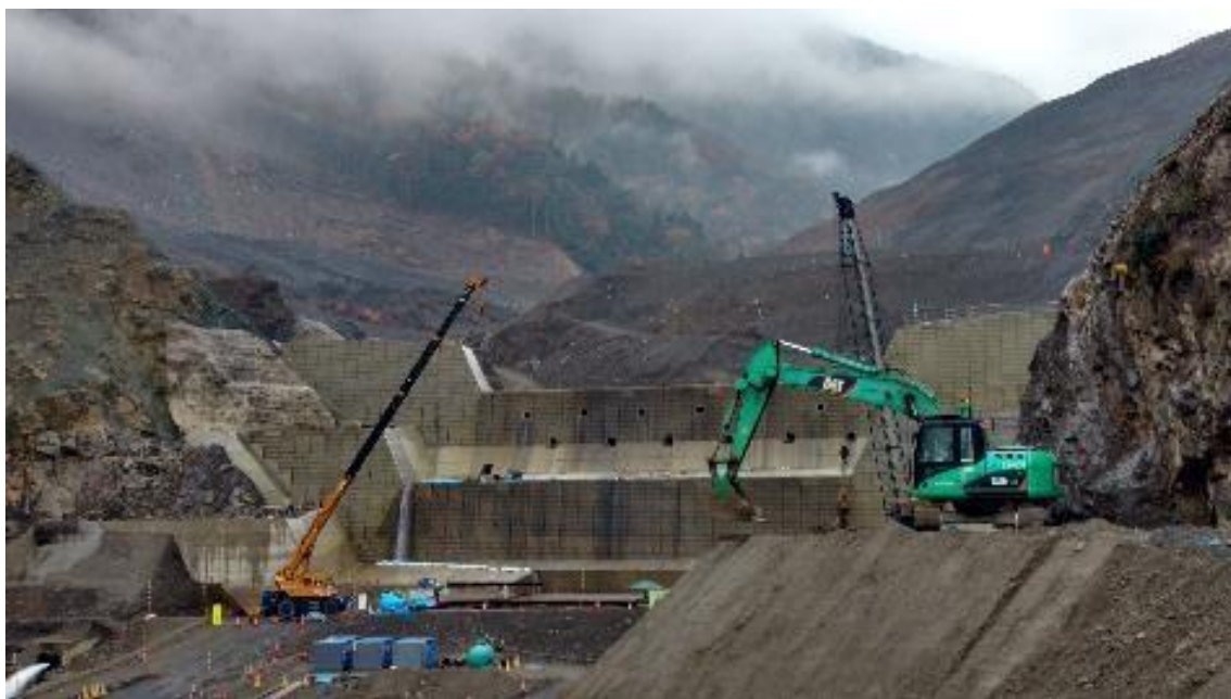
Figura 24. Exemplo de barragem Sabo impermeável
