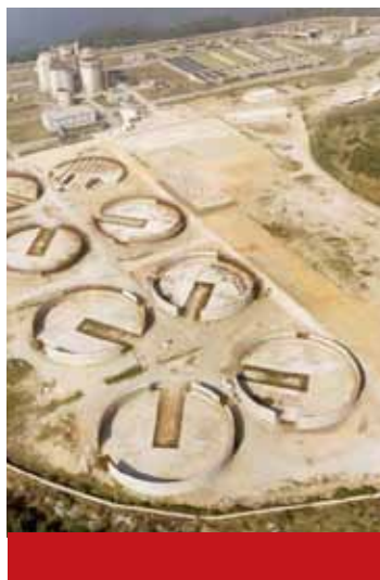
► Tratamento de Esgoto (RJ)
