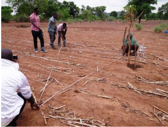
Photo 1 : Mesure de champ ; Tracée d'angle droit utilisant le théorème de Pythagore
