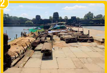
西参道の修復
