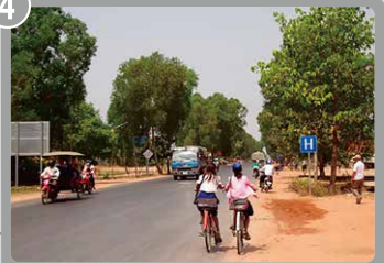
国道6号線の改修
