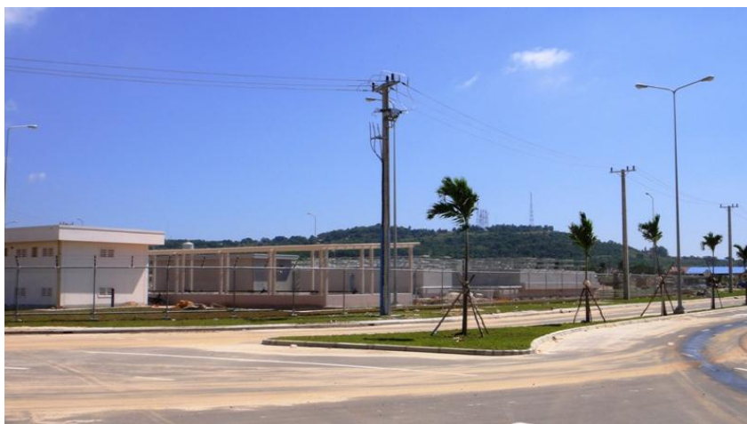
下水処理プラント
