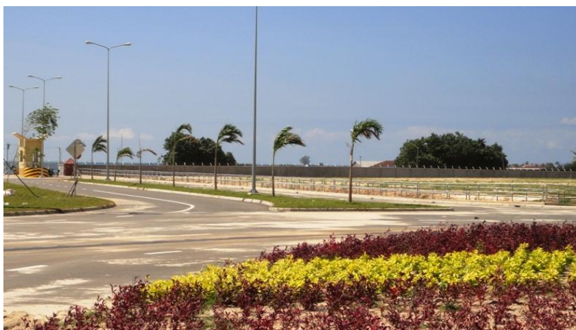
海側からのアクセスロード
