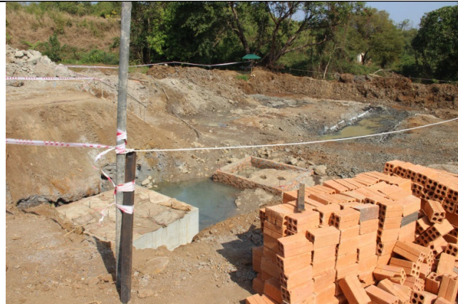
写真3：オチュム第1発電所の基礎工事の様子。完成すれば265kWの発電が可能となる。
