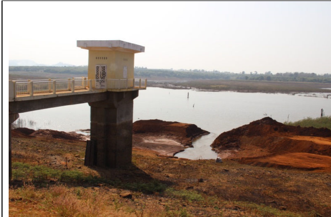
写真1：オチュム第1ダム。取水塔の周りを土で締め切る工事を開始。
