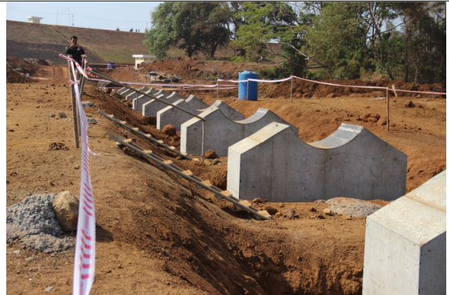
写真2：オチュム第1ダムから、オチュム第1発電所に導水するための基礎工事の様子。
