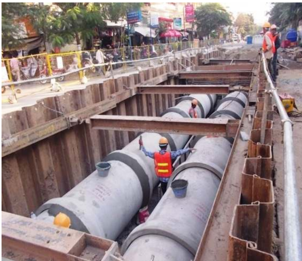
排水管網の敷設工事の様子
