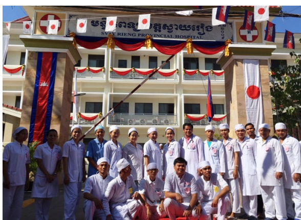
完成したスバイリエン州病院新棟と医療従事者
