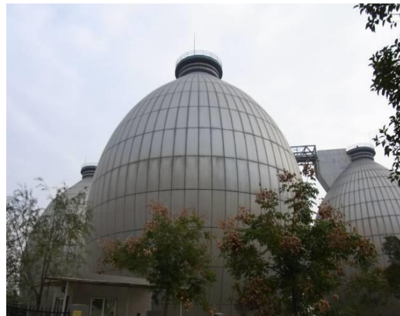
图 5 袁乐村污水处理厂的污泥消化槽
