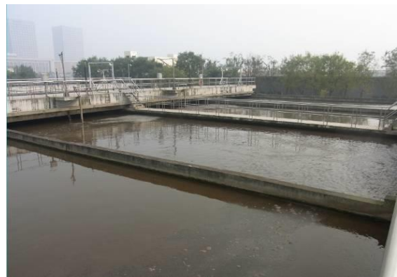
西南郊地区污水处理厂生物反应池
