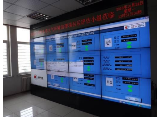
图片 3 SCADA 系统 (安装于燃气公司总部)
