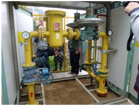
照片 2 安装于住宅小区的调压柜
