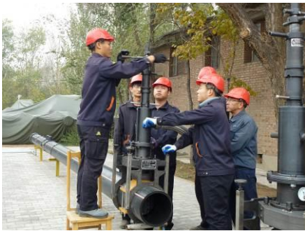
照片3 进修所燃气管更换作业实地演练
