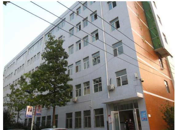
本项目建设的教学楼 (河北女子职业技术学院)
