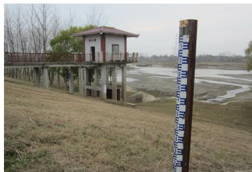
堤坝和水闸（孝感市）
