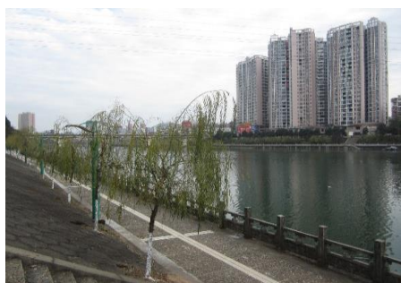
建成的堤坝（赤壁市）
