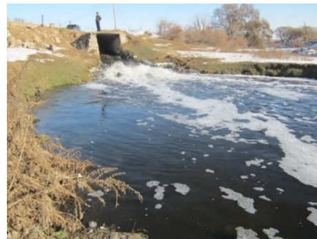
章盖营污水处理厂排放到 小黑河支流的处理水
