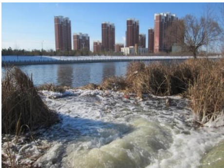
辛辛板污水处理厂排放到 小黑河的处理水
