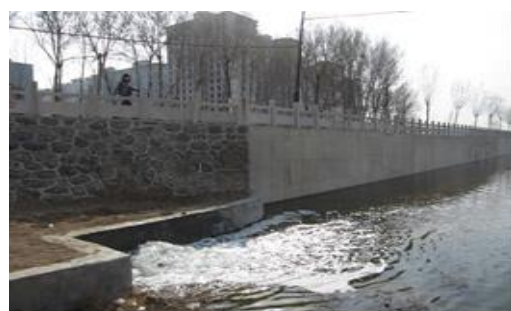
公主府污水处理厂被排放至小黑河支流的处理水
