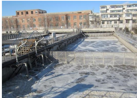
公主府污水处理厂的生物反应槽
