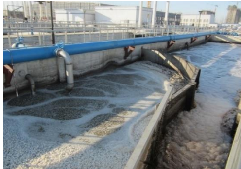
辛辛板污水处理厂的吸附池
