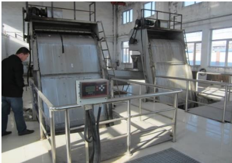
章盖营污水处理厂的进水过滤器
