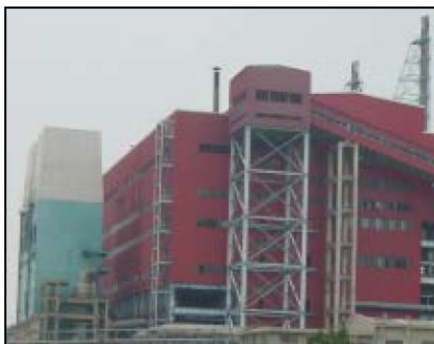
项目照片：云南化肥厂黄磷成套设备外观
