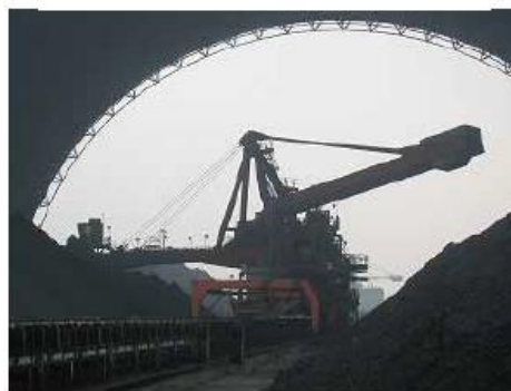
图2 燃煤搬运设备
