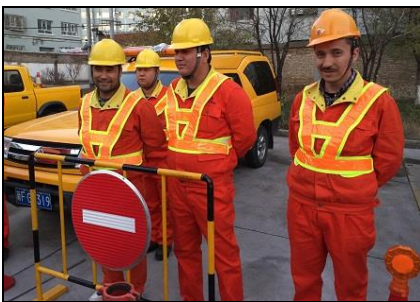
供水管道的检查维修队伍
