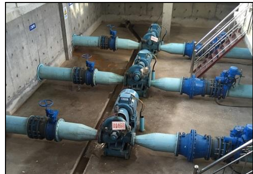
供水设施完善项目建成的水泵
