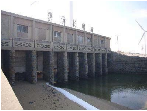
莱州市丁字坝（新建工程）
