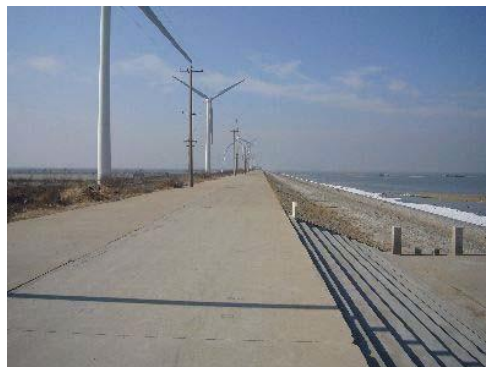
莱州市防潮堤 (改建工程)
