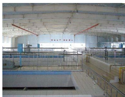
烟台经济技术开发区第二净水厂
