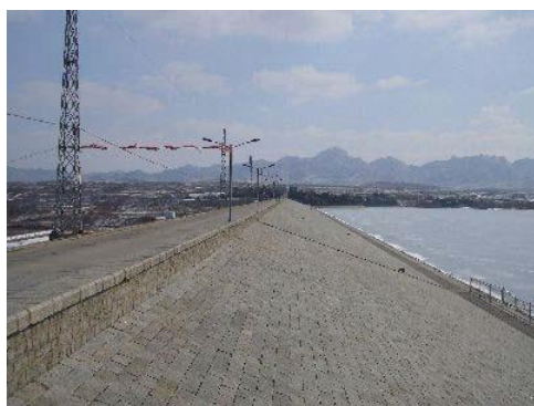
龙口市王屋水库 (改建工程)
