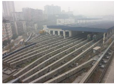
图3 车辆段（毗邻大堰村站）实景
