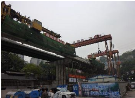
图7 在建的单轨3号线
