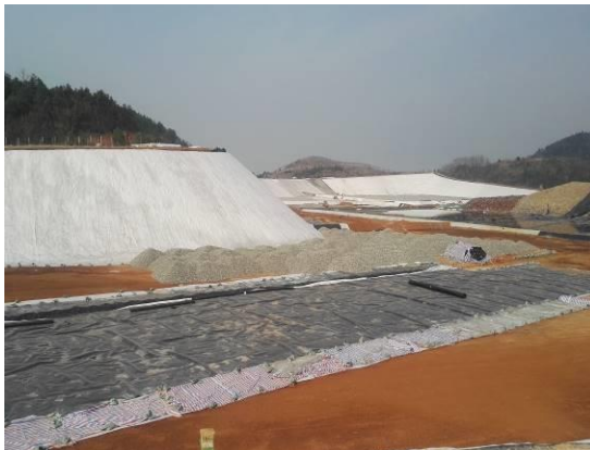
本项目建设的垃圾填埋场（华容）
