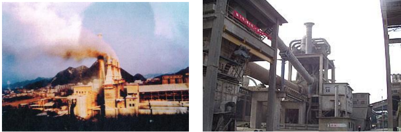
（资料来源） 中日友好环境示范城市（贵阳）项目报告书2006年、水泥厂相关人员提供图片 贵州水泥厂的大气污染（项目实施前） 贵州水泥厂新建发电设备（项目实施后）
