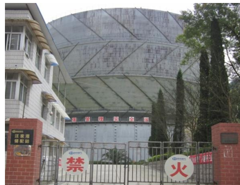
贵阳市城市燃气储气罐
