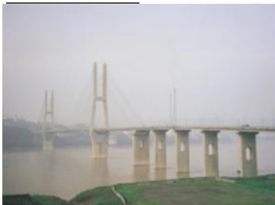
武汉长江第二大桥全景
