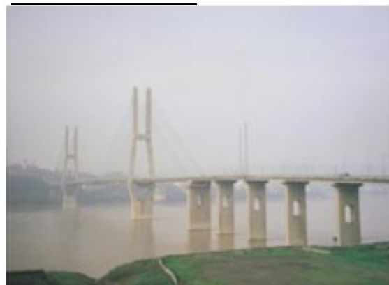
武汉长江第二大桥全景
