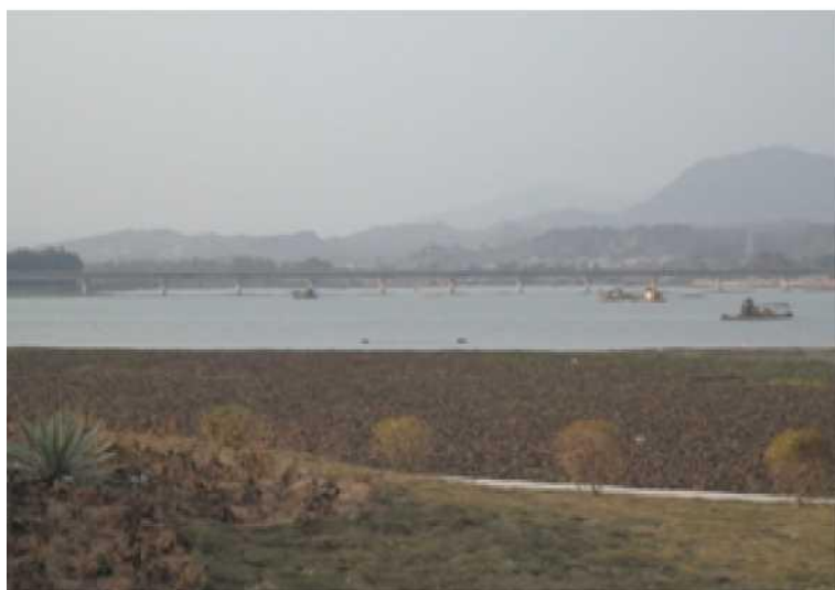
洛阳江特大桥 (1308m)
