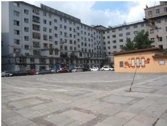
本项目中小型锅炉拆除后建成的娱乐广场
