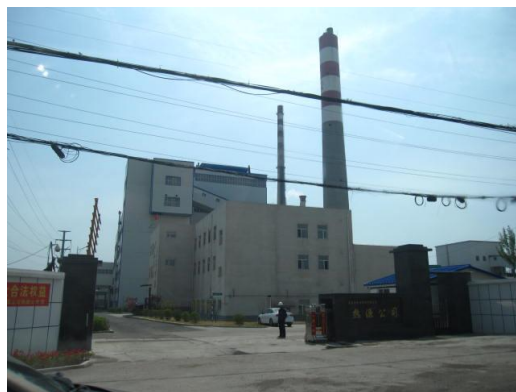
本项目中建设的燃煤锅炉厂
