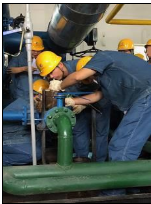
在本项目建设的换热站实施技术培训的情形
