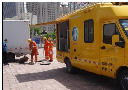
对本项目建设的供热管道进行维护的情形
