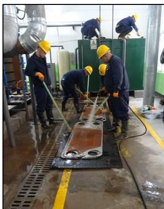
在本项目建设的换热站对换热片进行定期维护的情形
