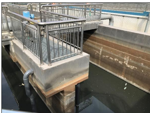
停工的第3污水处理厂
