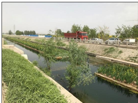
本项目建设的污水处理厂附近的排水沟 (银川市)
