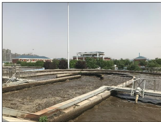
本项目建设的第 5 污水处理厂
