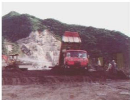
工序 1 使用自卸汽车卸下混凝土
