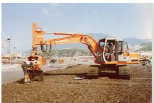
工序 3 使用切缝机形成横接缝
