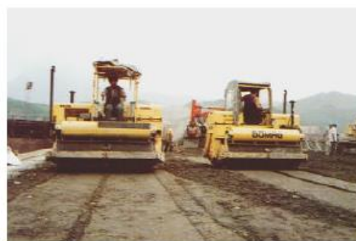
工序 4 使用压路机将混凝土压实
