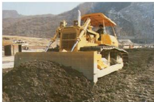
工序 2 用推土机压平
