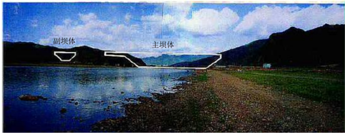
图 3 观音阁水库坝址
