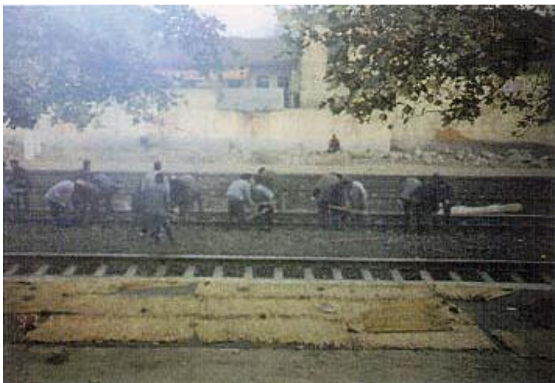
人力养路作业（夯固枕木下的路基） （西安-宝鸡段）
