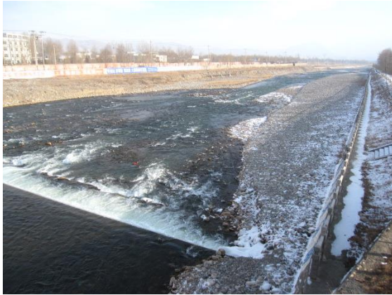
本项目建设的河流护岸工程
