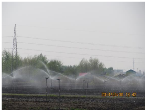
本项目建设的喷淋设备
